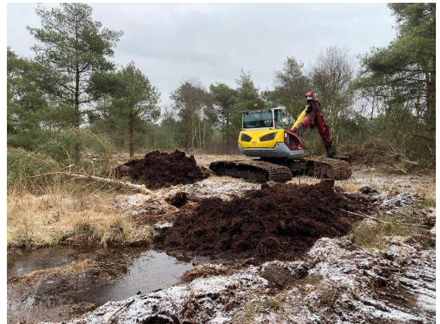
Ein leichter Bagger mit bodenschonendem Moorlaufwerk legt in den zentralen Hochmoorflächen neue Dämme und Grabenstau an. Was zunächst etwas brachial wirkt, soll in Zukunft der schleichenden Austrocknung des Moores entgegenwirken. (Foto: I. Lemke)
