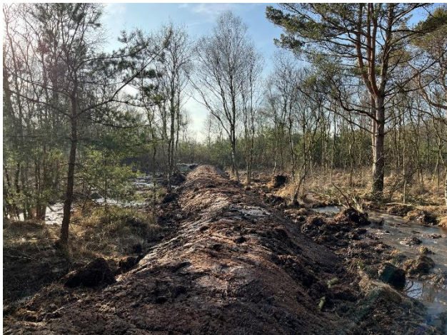
Eine der neu angelegten Verwallungen im Bokeler Moor. Diese vermindern den Abfluss von Regenwasser aus dem zerklüfteten Moorkörper, so dass eine positive Wasserbilanz und damit die Voraussetzung für ein wachsendes Hochmoor geschaffen wird. (Foto: I. Lemke)
